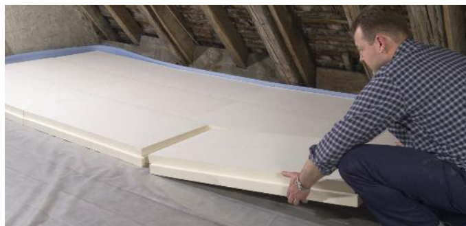
Dämmung der obersten Geschosßdecke mit LINITHERM PGV
