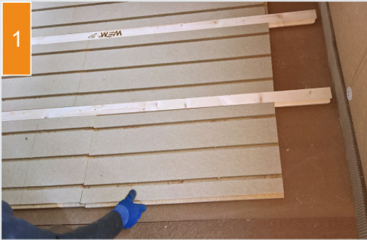
(1) Die Holzfaser-Verlegeplatten und Profilleisten werden ausgelegt.
