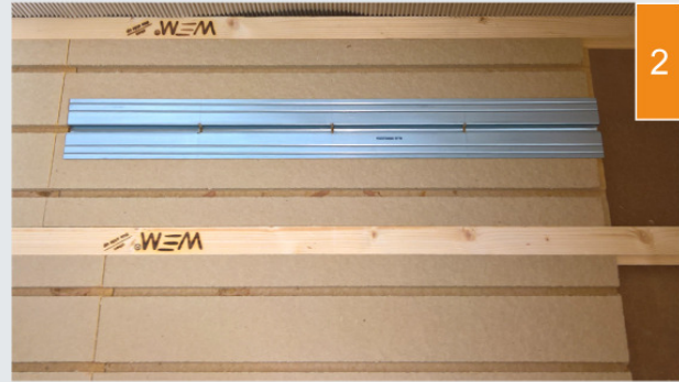
(2) Wärmeleitbleche werden in die Verlegeplatten eingelegt.
