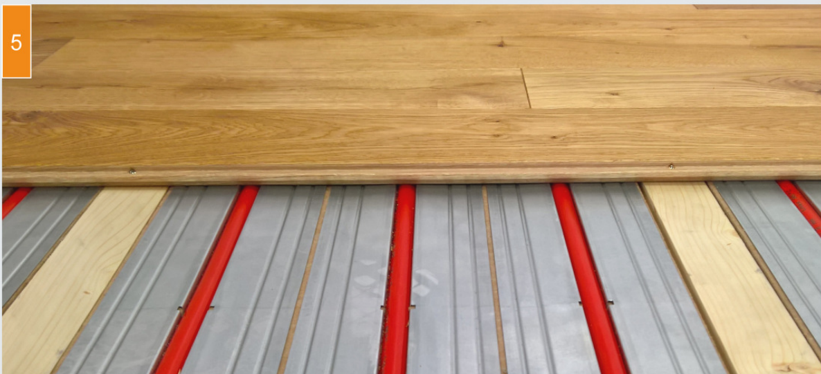
(5) Der Bodenbelag wird verlegt (in diesem Beispiel Holzdielen).
