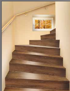
Verkleidung mit Treppenkanten bei einer innenliegenden Treppe
