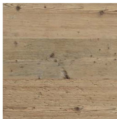
Originale Fußboden Oberfläche
