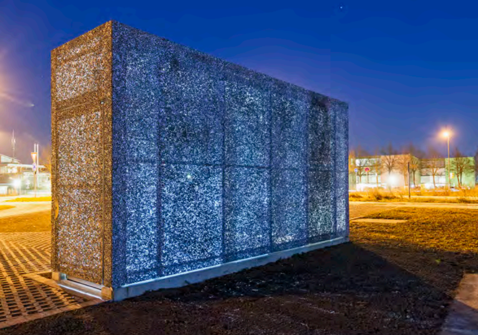
AL-FG-12.7-LG-2S (große Zellen, beidseitig geöffnet), 3 m Plattenlängen, hindlschieneis architekten, Foto: Eckhart Matthäus
