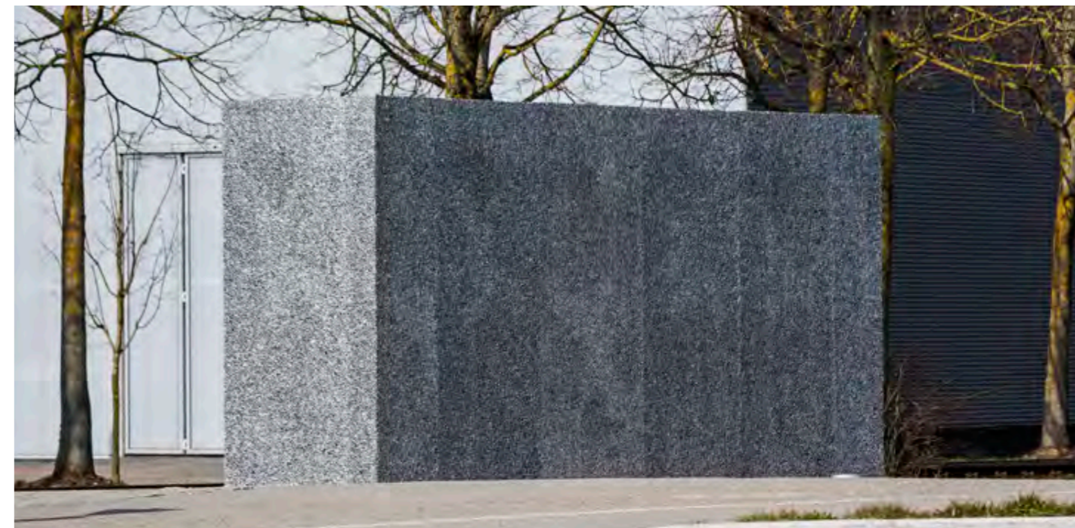
Innovationspark Augsburg, Einstiegsbauwerk Fassade Alusion, Foto: Eckhart Matthäus
