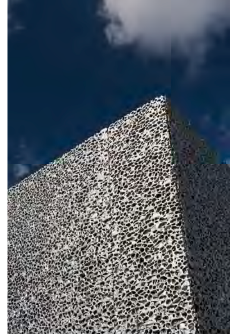
Oberfläche aus 100% recyceltem Aluminium, Foto: Eckhart Matthäus
