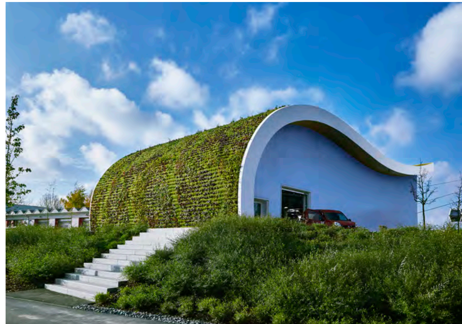
Live Panel als Dachbepflanzung, im Rahmen der Internationalen Gartenausstellung, Foto: Hermann Haubrich, www.hhaubrich.de
