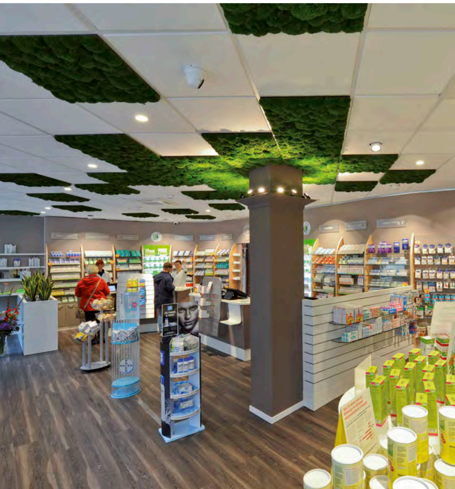
Ein einfaches Dachkassetten-system wird durch Greenhill im Format 500 x 500 mm naturschön umgesetzt und bringt zudem eine gute Ladenakustik.
