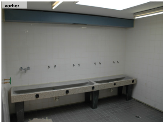
Duschräume, Schulsporthalle, Stade
