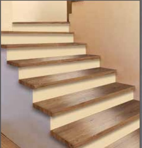
Verkleidung mit Treppenkanten bei einer einseitig freistehenden Treppe
