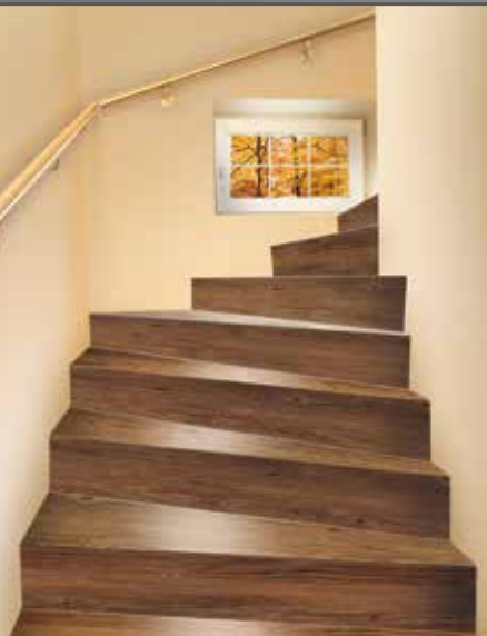
Verkleidung mit Treppenkanten bei einer innenliegenden Treppe
