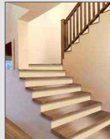
Treppenkanten mit „Nase“ bei einer Treppe, die nur an einer Seite von einer Wand begrenzt ist. Die Treppenkante ragt vorne und seitlich über die Stufe hinaus.
