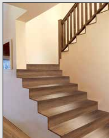
Verkleidung einer Treppe, die nur an einer Seite von einer Wand begrenzt ist. Die Treppenelemente sind auch seitlich verblendet und schließen bündig mit der Mauer ab.
